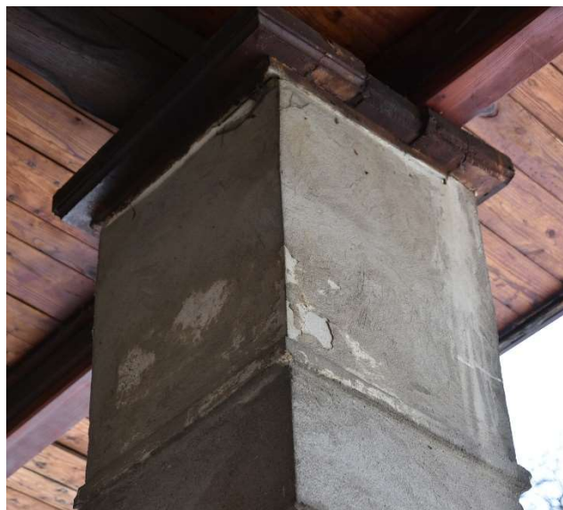
Fot. 31. Odpadające tynki na filarze
