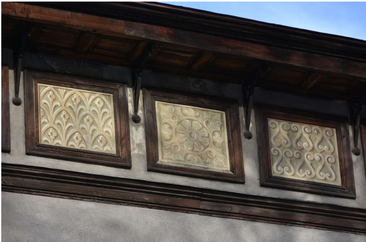
Fot. 49. Malowidła na elewacji południowej
