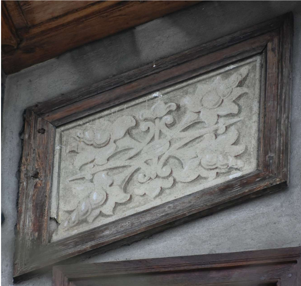
Fot. 47. Odspojony fragment malowidła (widoczny w lewym dolnym narożniku)
