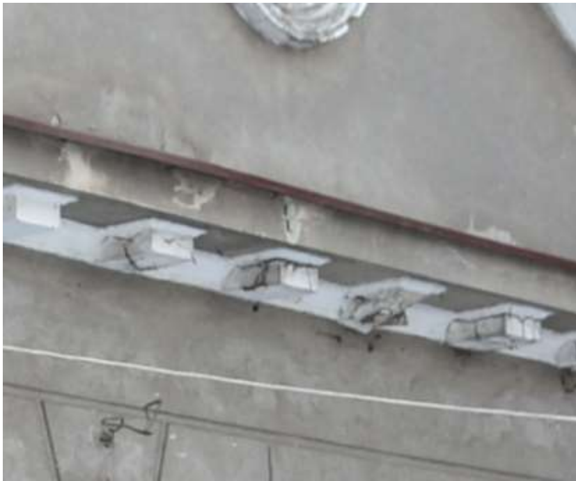
Fot. 22. Fragment dolnego gzymsu frontonu kaplicy
