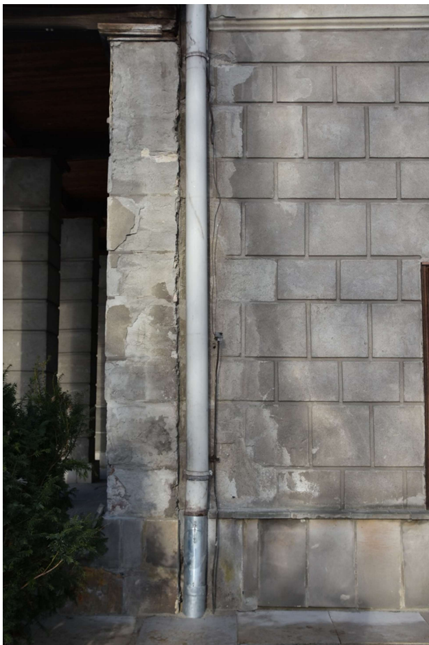
Fot. 5. Odspojone i pudrujące się tynki
