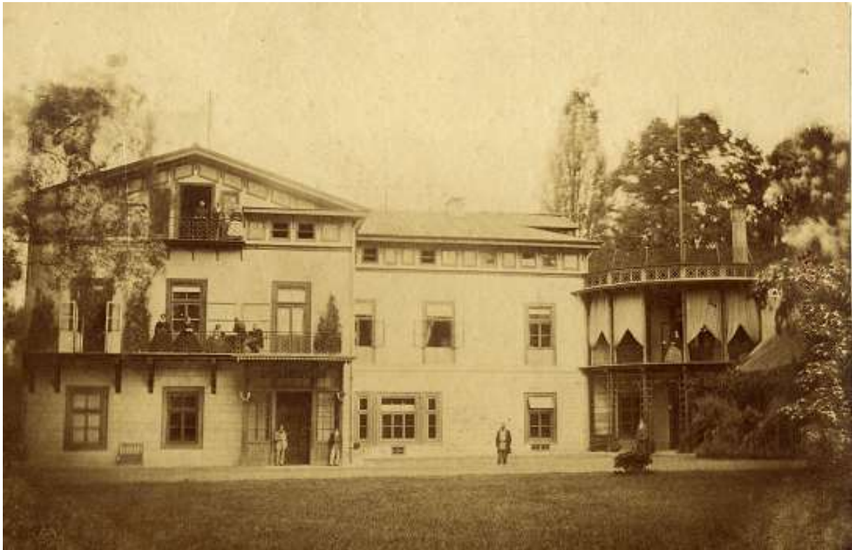
Fot. 3. Elewacja wschodnia na zdjęciu archiwalnym z ok. 1864 r.*
