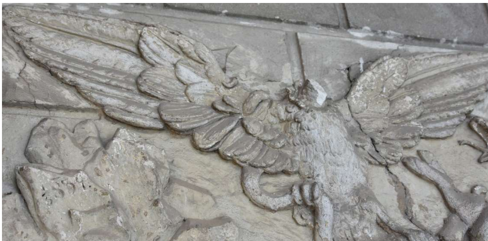
Fot. 40. Ozdobny kartusz widocznym pęknięciem i ubytkami formy rzeźbiarskiej
