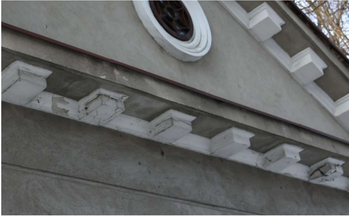
Fot. 17. Fragment gzymsu frontonu kaplicy (spękania i łuszcząca się farba)
