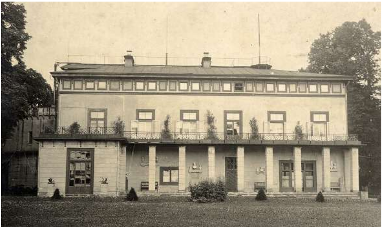
Fot. 2. Elewacja zachodnia na zdjęciu archiwalnym z ok. 1939 r. *
