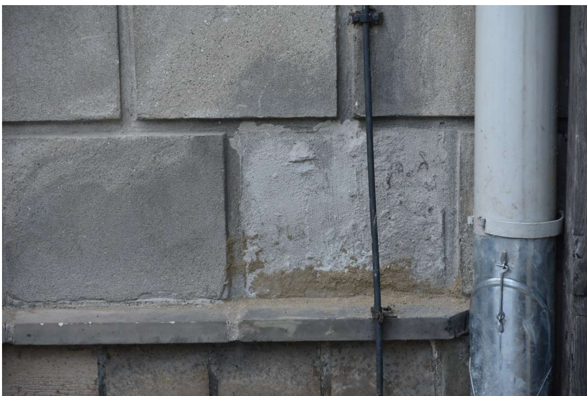
Fot. 12. Nieprawidłowo wykonana naprawa tynków w strefie nad cokołowej
