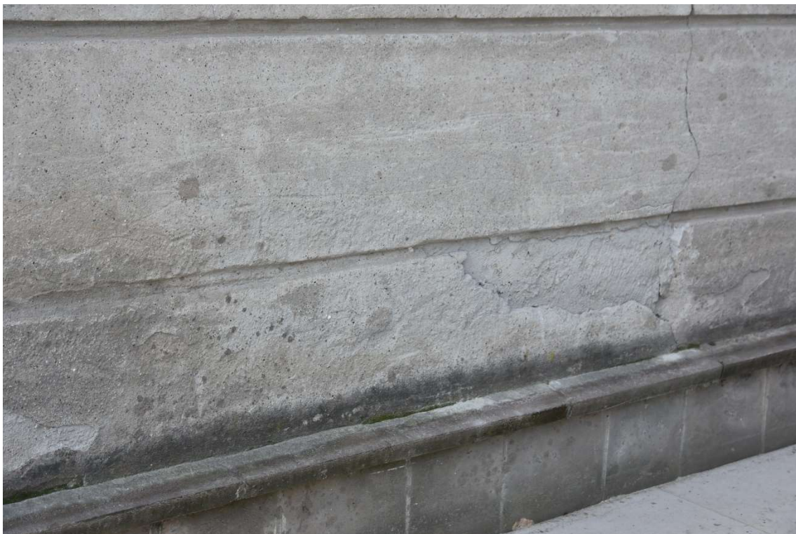
Fot. 14. Odspojone i pudrujące się tynki
