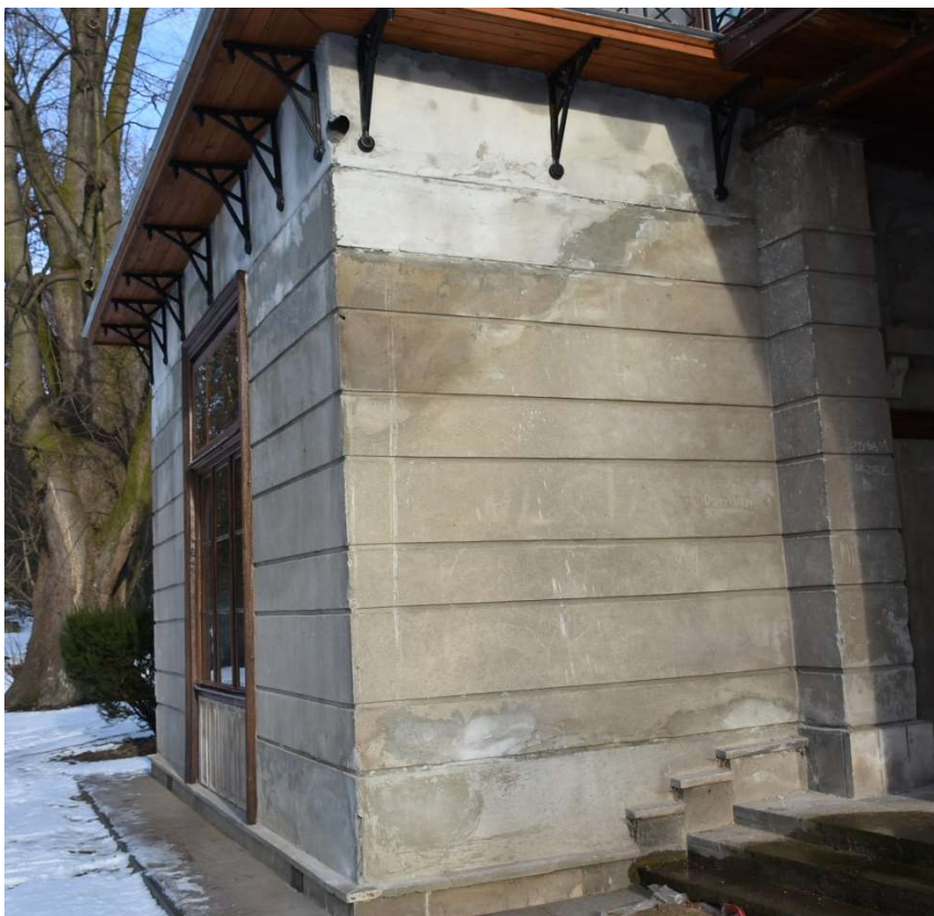
Fot. 25. Południo-zachodnia elewacja Sali Mieszczkańskiej
