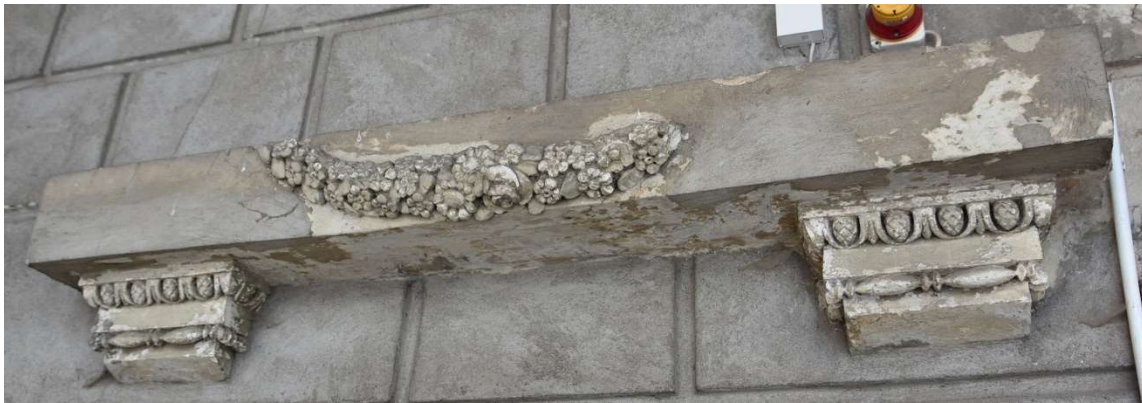
Fot. 38. Gzyms parapetowy pokryty cementową zacierką i warstwą farby
