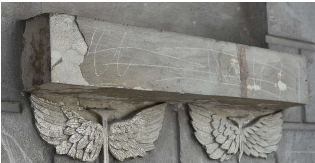
Fot. 39. Gzyms parapetowy pokryty cementową zacierką
