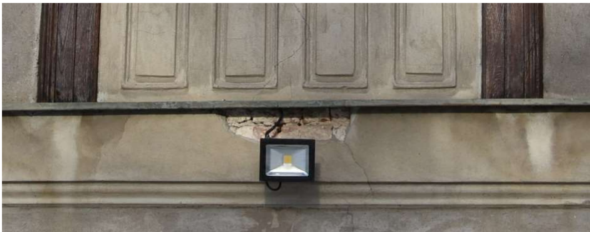
Fot. 7. Fragment brakującego tynku
