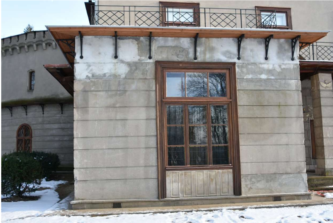
Fot. 24. Zawilgocenia i zasolenia na zachodniej ścianie Sali Mieszczkańskiej
