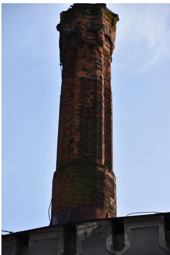
Fot. 16. Ceglany komin
