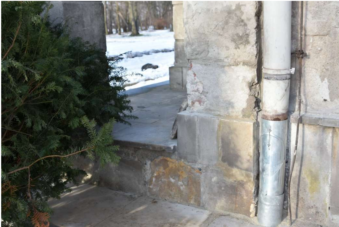
Fot. 6. Korozja biologiczna i wykwity solne
