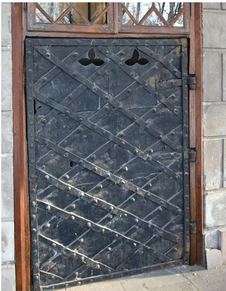
Fot. 34. Metalowe skrzydło drzwi wejściowych do piwnicy
