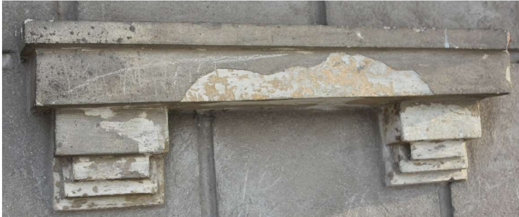
Fot. 37. Gzyms parapetowy pokryty cementową zacierką
