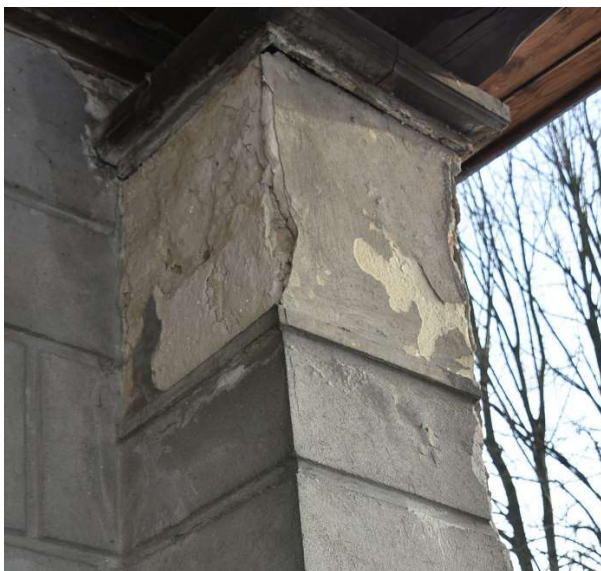
Fot. 32. Odparzone tynki na pilastrze (część górna)
