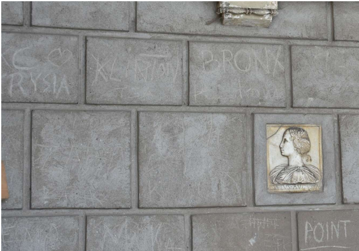
Fot. 27. „Pseudo graffiti” na ścianach podcieni
