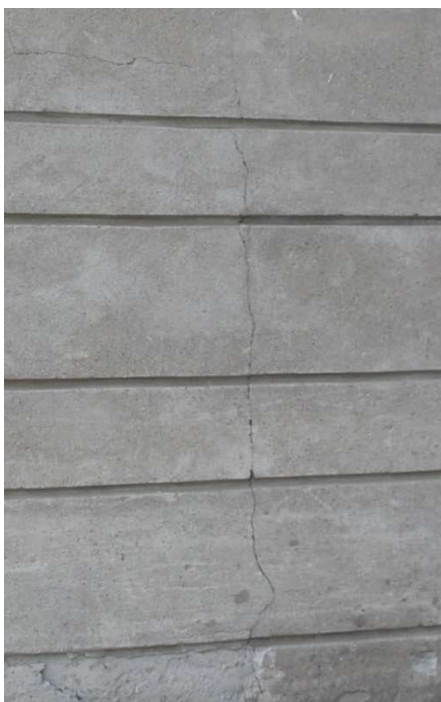
Fot. 15. Pęknięcia ścian
