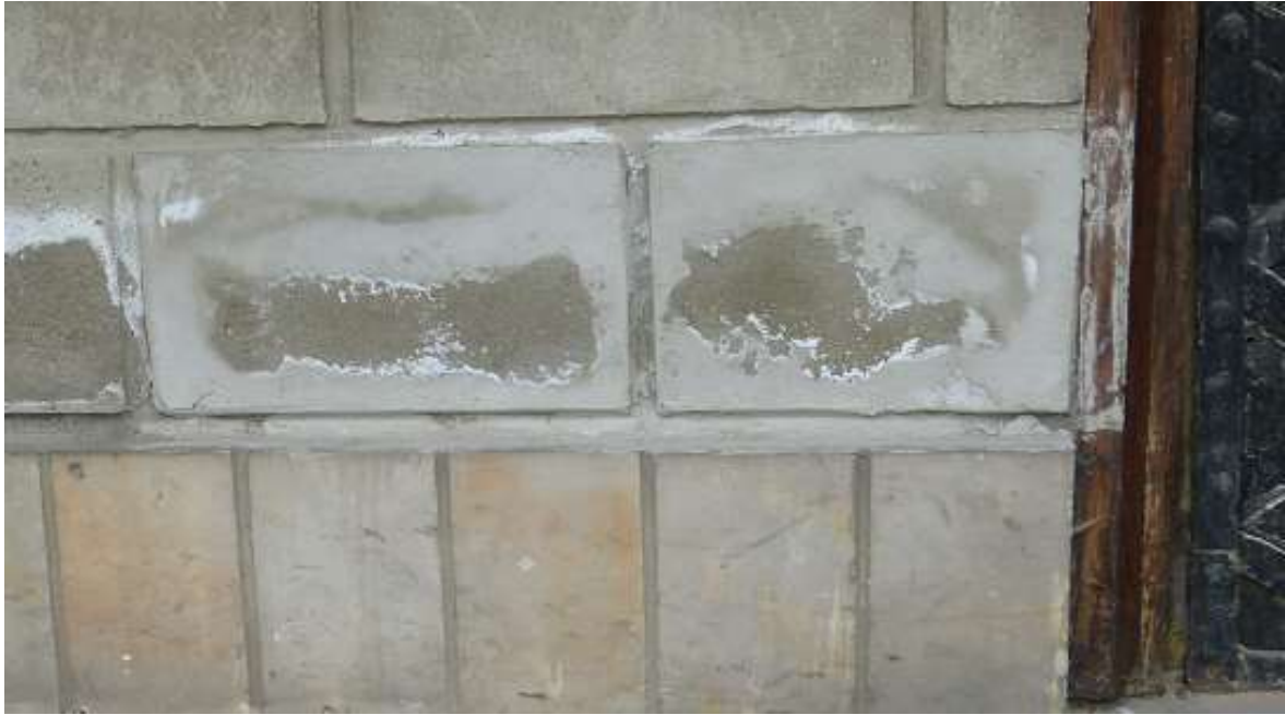
Fot. 28. Zasolenia w strefie nad cokołowej
