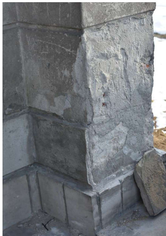
Fot. 33. Odparzone tynki na pilastrze (część dolna)
