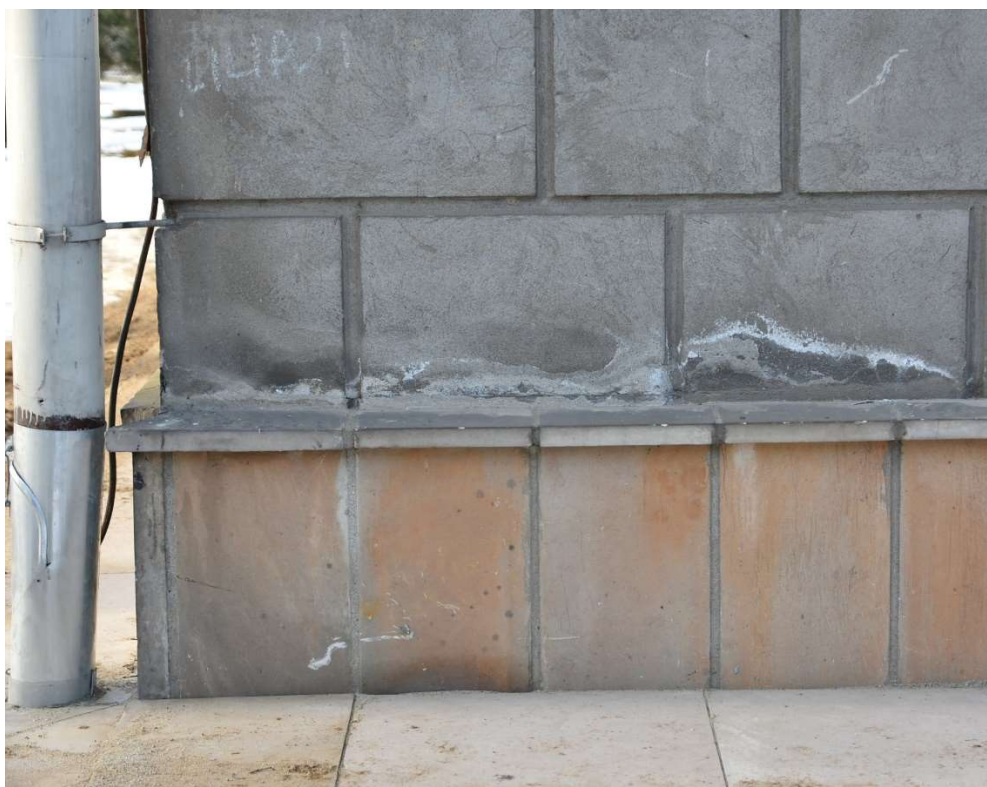
Fot. 10. Wykwity soli w pasie nad cokołowym
