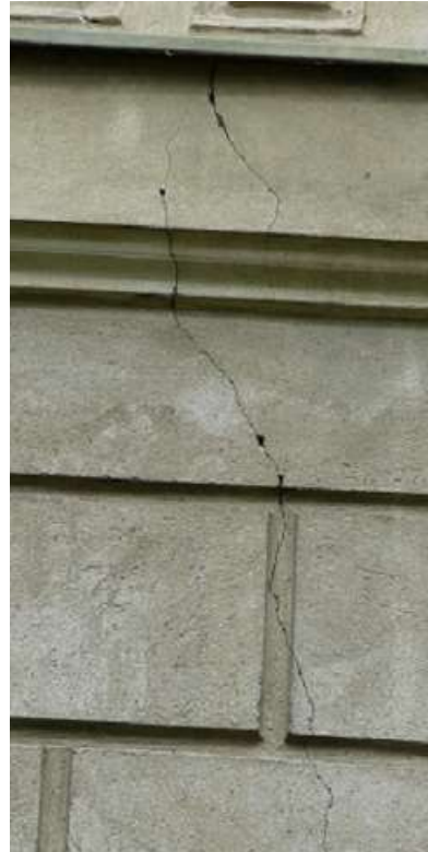
Fot. 8. Rysy przechodzące przez gzyms oddzielający I kondygnację od parteru
