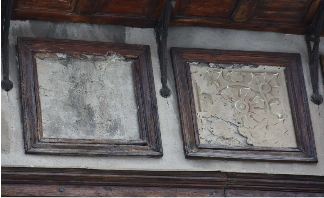
Fot. 48. Malowidła na elewacji zachodniej
