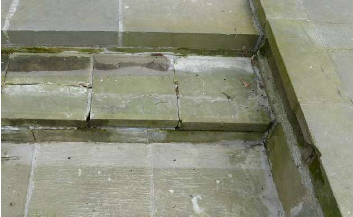
Fot. 26. Stopnie prowadzące do galerii
