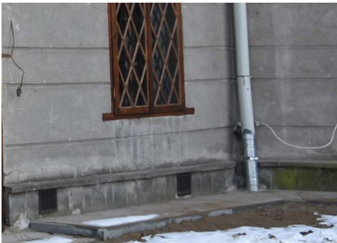
Fot. 19. Cokół oraz pas boniowania tuż nad cokołem
