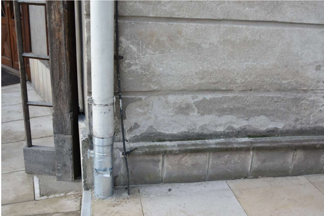
Fot. 13. Odspojone i pudrujące się tynki
