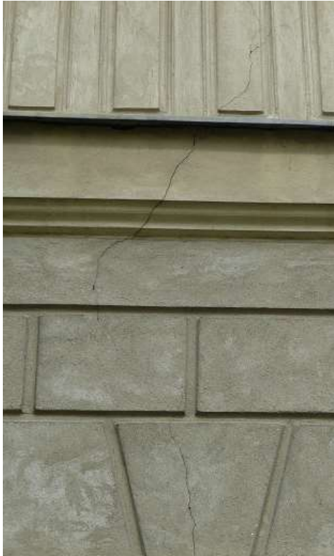
Fot. 8. Rysy przechodzące przez gzyms oddzielający I kondygnację od parteru
