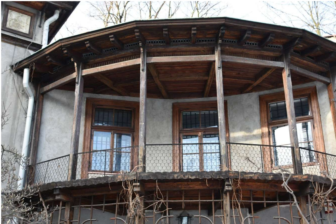
Fot. 18. Drewniana konstrukcja altany
