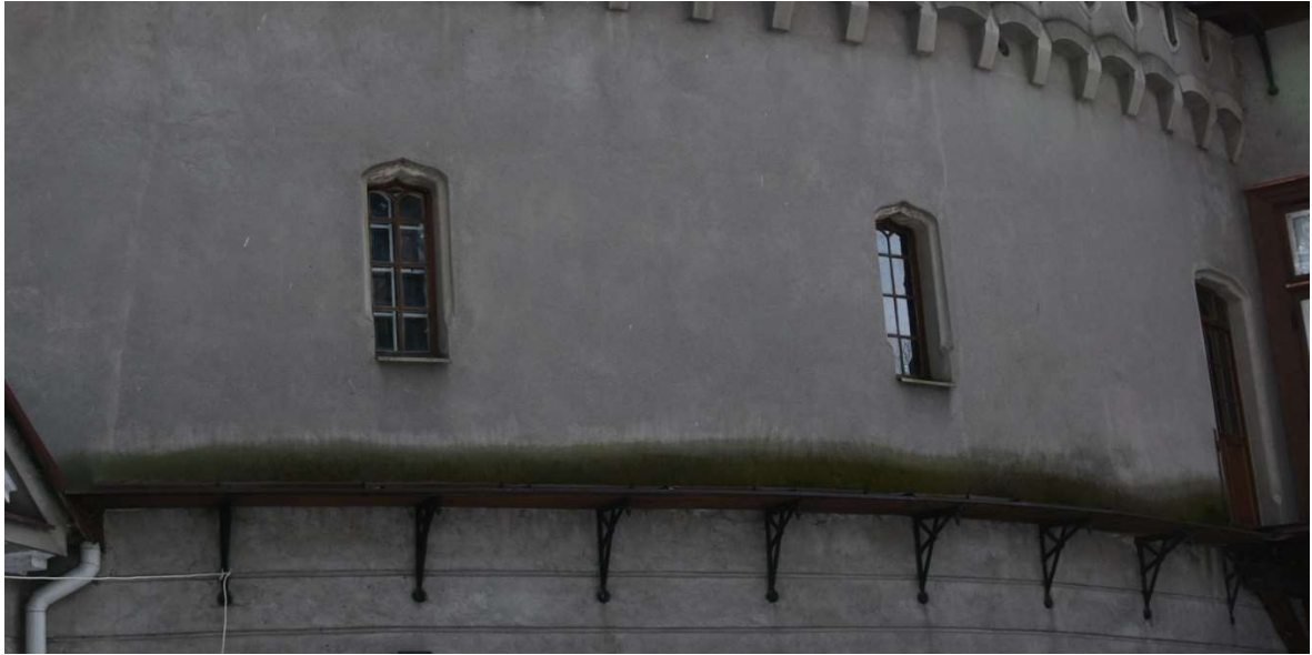
Fot. 20. Korozja biologiczna nad drewnianym gzymsem
