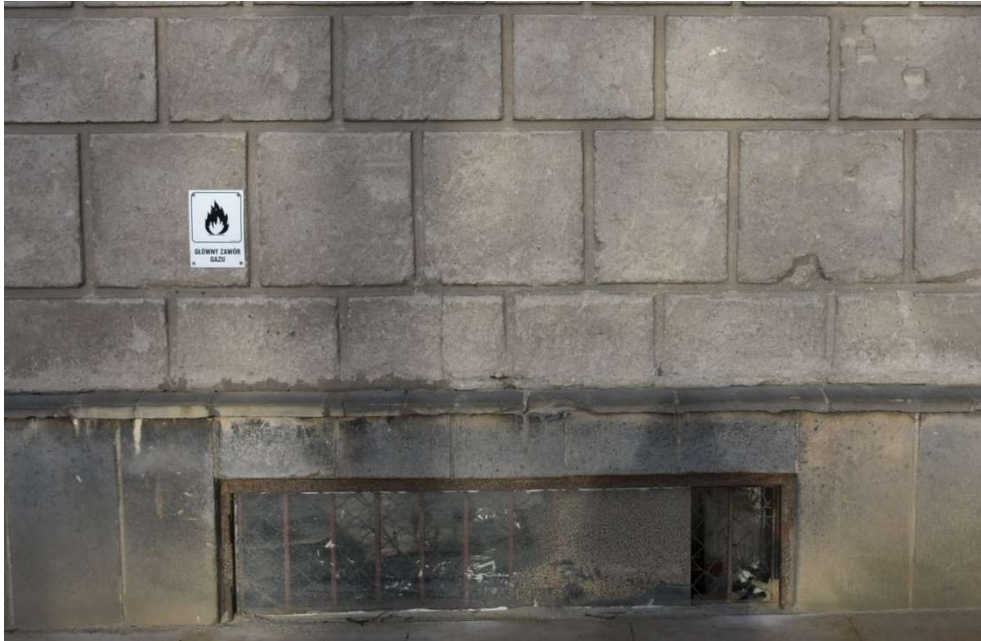
Fot. 4. Drobne ubytki wypraw tynkarskich, korozja biologiczna i zabrudzenia.
