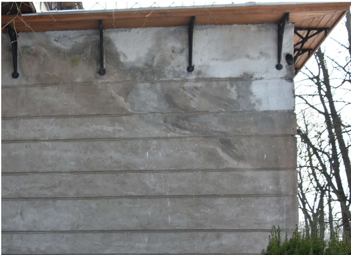
Fot. 23. Prawa górna część północnej ściany Sali Mieszkańskiej
