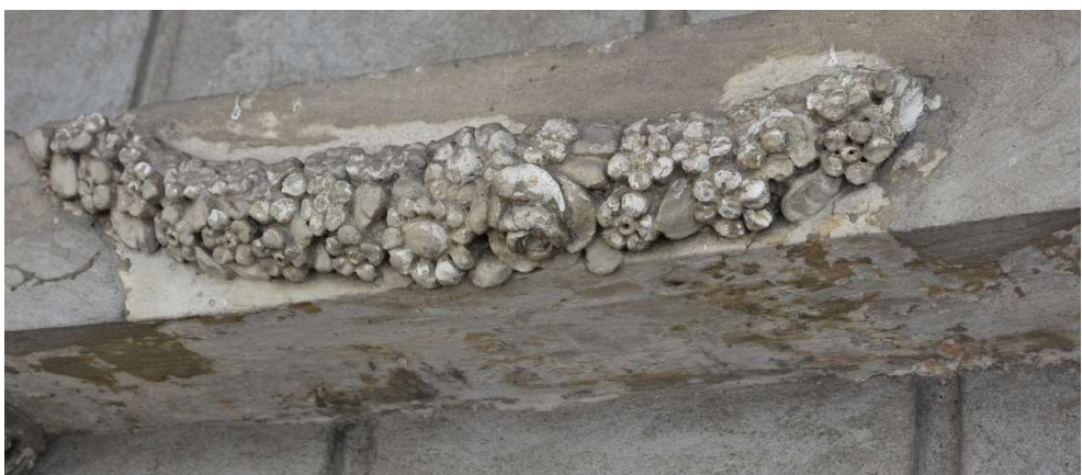
Fot. 41. Gruba warstwa farby oraz ubytek formy rzeźbiarskiej ozdobnej girlandy
